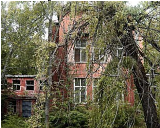
klinik_aussen1: der deutlich ältere und wesentlich kleinere Teil der Klinik von der südöstlichen Querseite gesehen, von dieser Seite sehr zugewachsen
