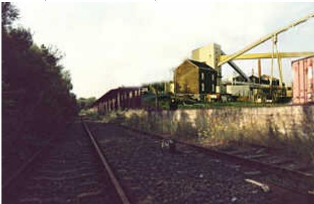
bahnhof3-gleis: Blick von dem Bahnhof in Richtung des östlichen Streckenverlaufs, alte Anlagen zeugen von früherer Bedeutung
