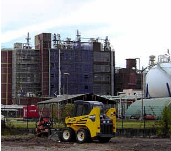
regenwasserfirma-hinten1: alles wurde gereinigt, verschönt und Landschaftsgärtner sind gerade dabei, das breite Areal hinter der Fabrik mit viel Aufwand gärtnerisch umzugestalten
