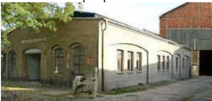
Pumpenfabrik 1: vorne links in dem Flachbau hinter der geöffneten Mitteltür befindet sich die Pumpenwerkstatt.
