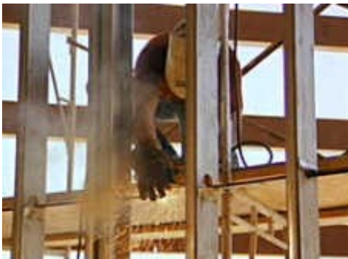
Regenwasserfirma1: in der alten Halle wird noch kräftig gewerkelt und umgebaut, dass „die Funken sprühen“.
