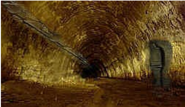
Stollengang1: ein schier endloser, tunnelartiger Stollengang beginnt im Damm neben dem Weg
