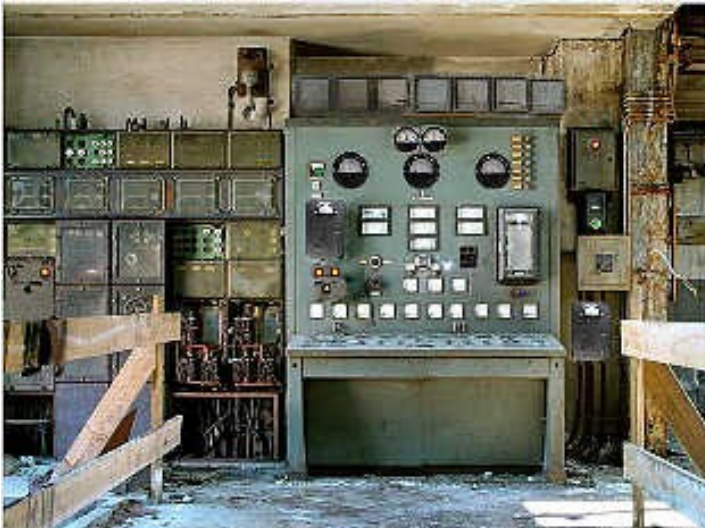
Zukunftshalle-innen5: alte Leitwarte, die wohl teils noch unter Strom steht
