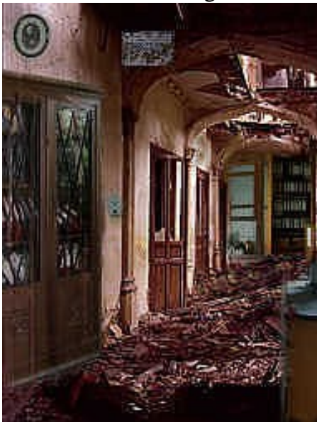
Villa-innen3: im ersten Stock liegt im Flur schon der Schutt von eingestürzten Decken darüber liegender Stockwerke
